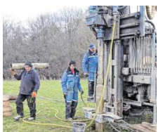
In der Au: Die Brunnenbauer gehen auf 29 Meter. BILD: THORSTEN LANGSCHIED
